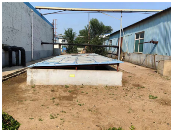
冷凝水收集池
