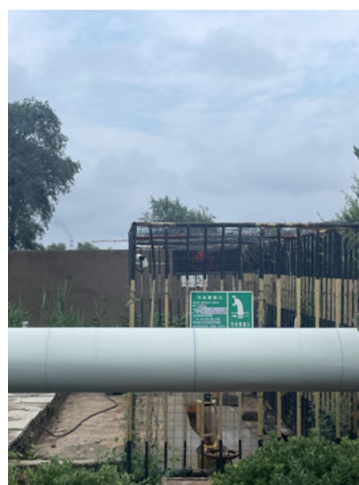
污水总排放口
